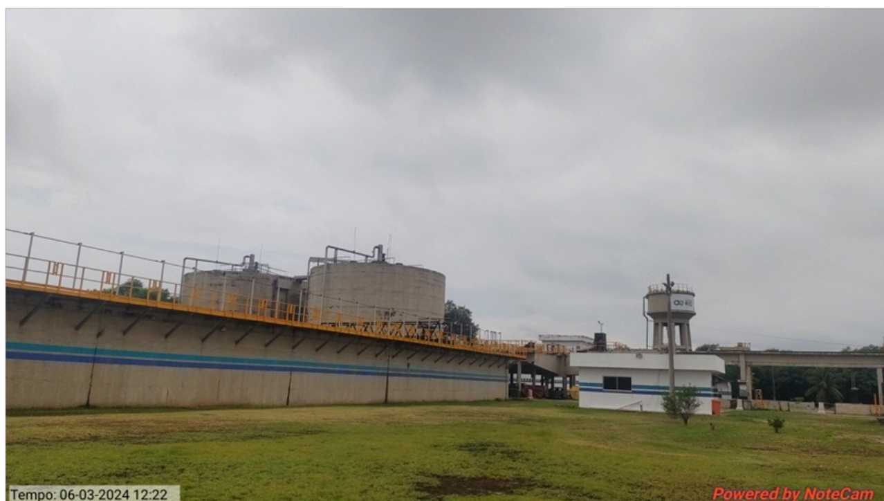
Foto 1 – Vista ampla ETE
