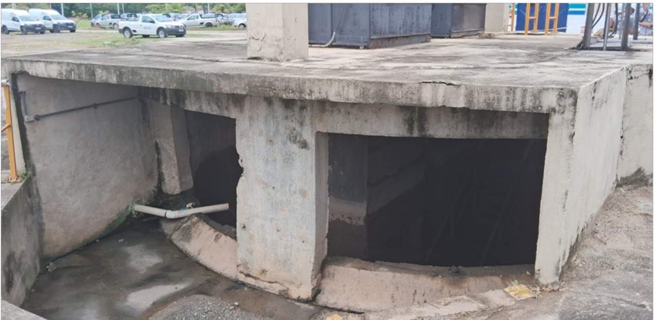
Foto 5 – Caixa de chegada
