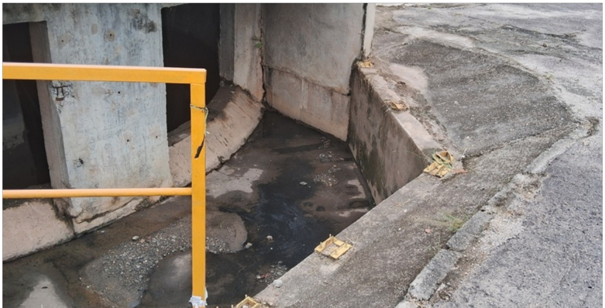
Foto 4 – Caixa de chegada
