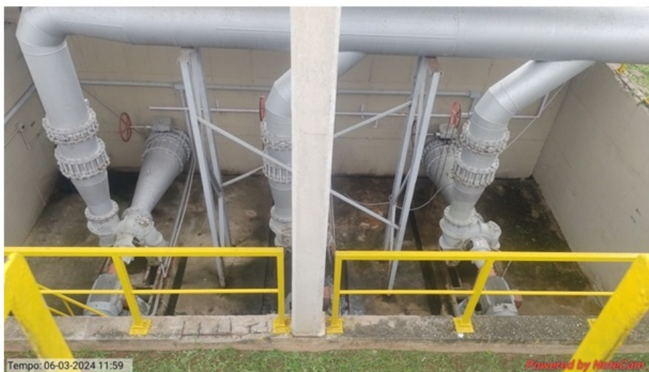
Foto 22 – Elevatórias de recirculação
