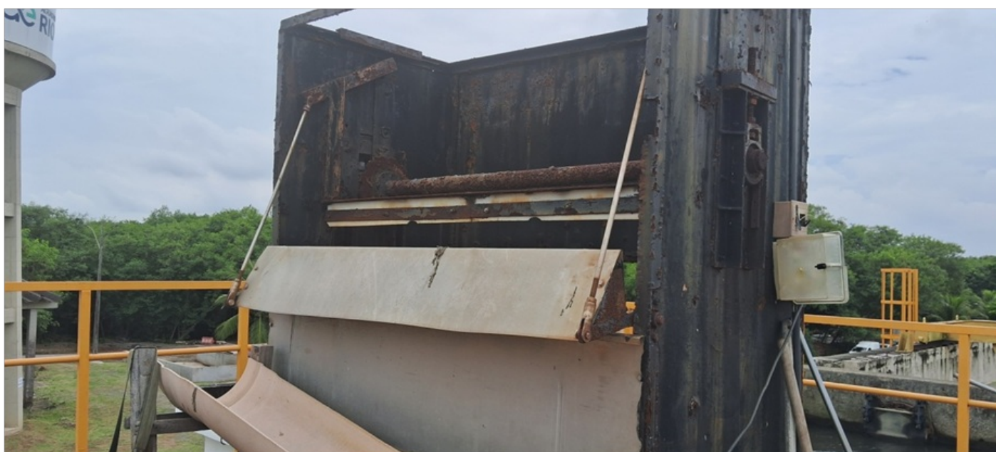
Foto 9 – Manutenção desenerador 2 e caçamba gradeamento fino
