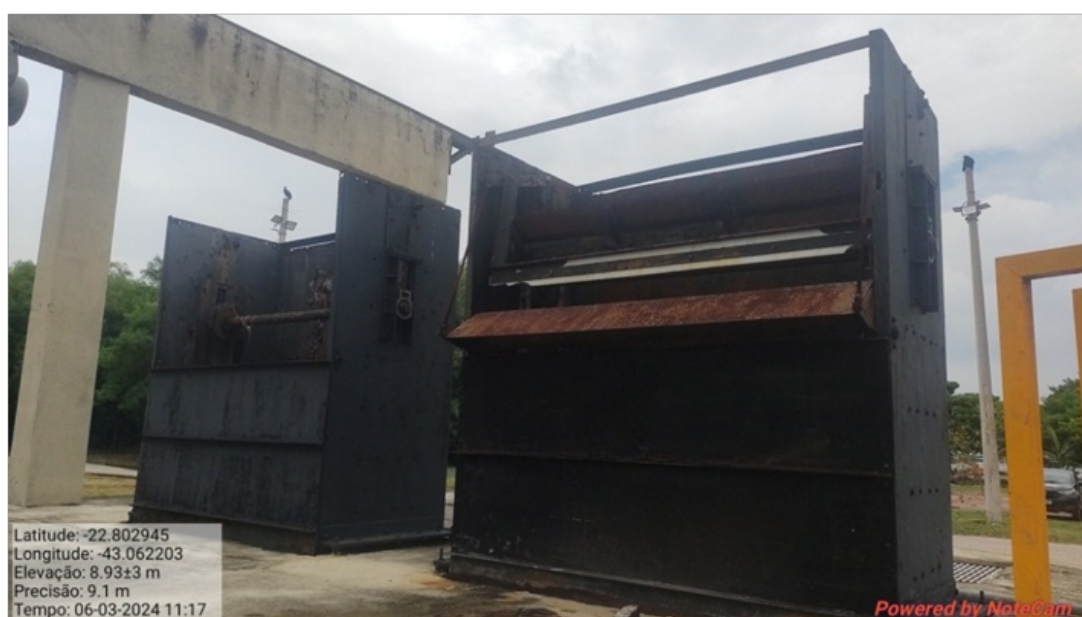
Foto 3 – Grades mecanizadas (gradeamento médio)
